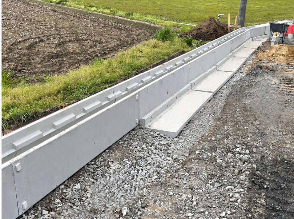
箱型U字側溝 土留め用底版
