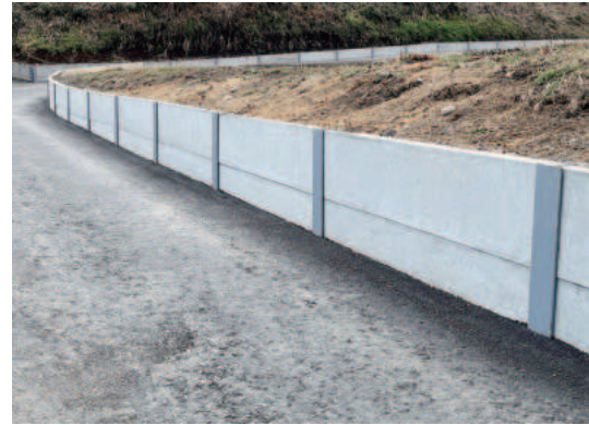
町道8-1056号線(城里町)
