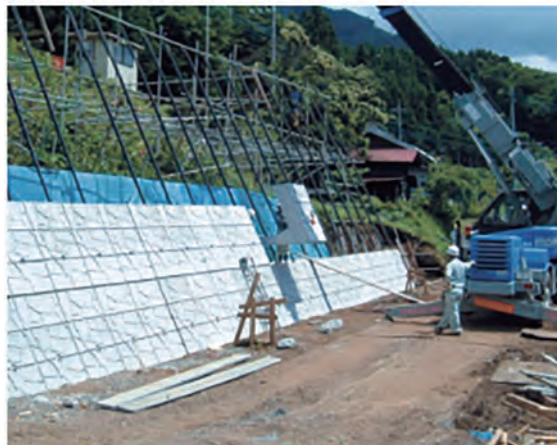
ブロック設置作業
