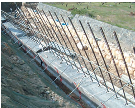
縦貫鉄筋設置
