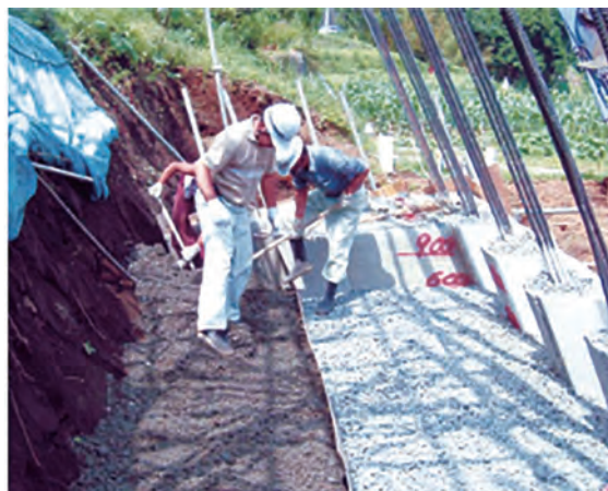
胴込・裏込砕石作業
