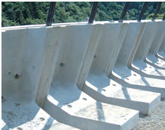
ブロック設置(背面)
