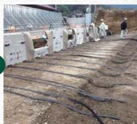
緊張用トレンチ設置
