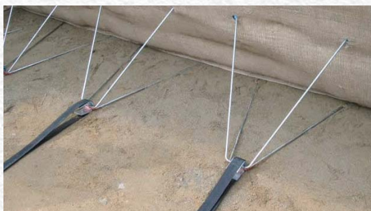
ストラップ設置
