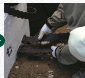
ストラップ設置
