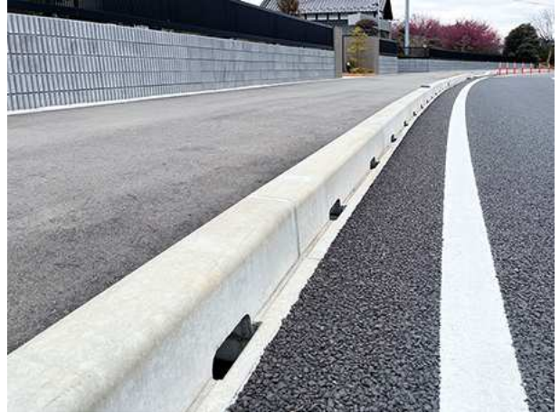
坂町清水線(守谷市)
