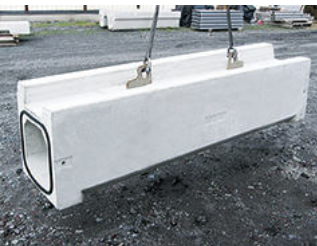
③製品吊り上げ・布設
