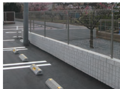
⑨施工完了
