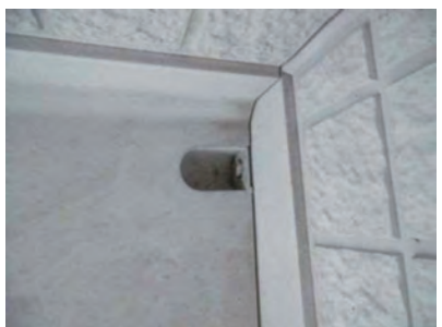
⑦連結部の締め付け(底版)
