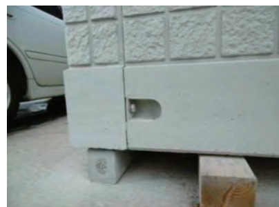
⑥連結部の締め付け(側壁)
