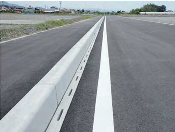
南国日章工業団地(高知県南国市)
